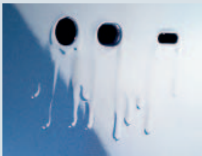
Rimozione di colature di vernice
