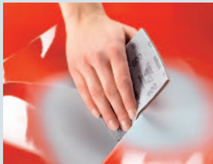
Acabado final de imprimaciones en puntos de difícil acceso
