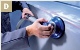
D Feinschliff von Füller/Gelcoat
