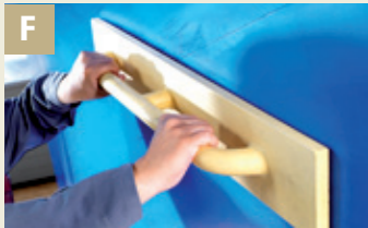
F Planschleifen von Grossflächen
